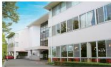
■老人保健施設 きのこ 老人保健施設 岡山県笠岡市
